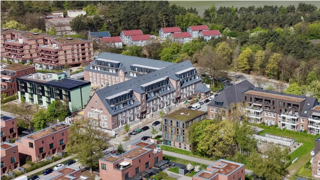
Die Fischbeker Höfe: Die Häuserzeilen links werden im August fertig. Ganz links: der schwarz-grüne Smoodje. Das Kasernengebäude rechts ist bezogen.
