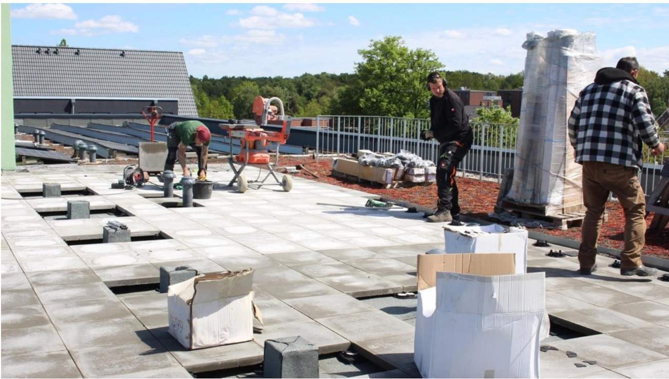
Auf dem Dach von Smoodje wird noch gearbeitet. © Angelika Hillmer | Angelika Hillmer
